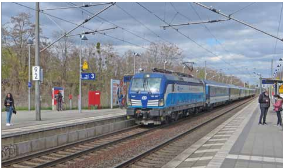
Planungsmangel: Der Regionalbahnhof an der Anhalter Bahn in Berlin-Lichterfelde Ost wurde lediglich als Haltepunkt ausgeführt, Überholungen sind somit nicht möglich. Die Regionalzüge hier deshalb nicht mehr halten zu lassen, ist aber eine völlig inakzeptable Lösung. Foto: Christian Schultz
