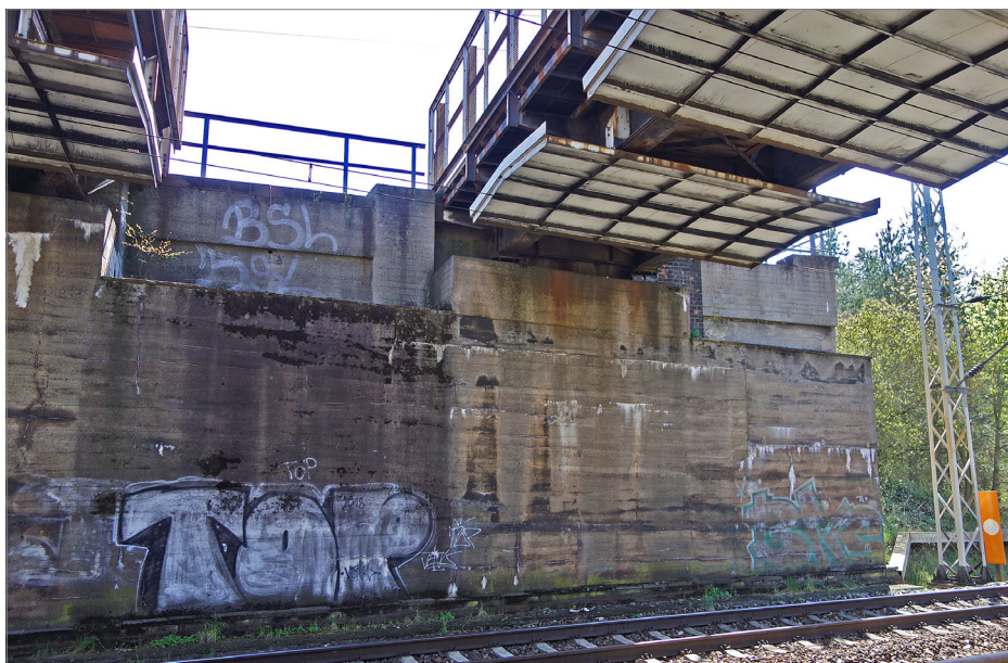
Das Kreuzungsbauwerk der Dresdener Bahn mit dem Berliner Außenring ist für eine Zweigleisigkeit der S-Bahn bereits vorbereitet. Das Bauwerk wird abgerissen und für zwei Fernbahngleise und nur ein S-Bahn-Gleis neu gebaut.
