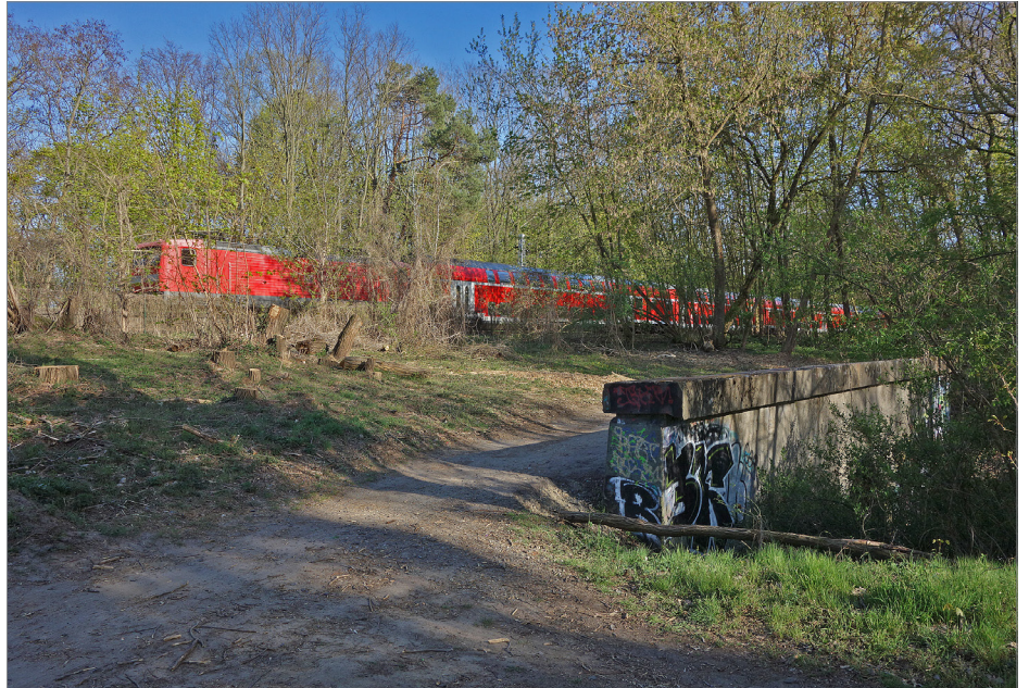
Südlich des Bahnhofs Blankenfelde ist der Durchlass des Glasowbachs bereits seit Reichsbahnzeiten für zwei S-Bahn-Gleise vorbereitet. Auch hier wird der Durchlass neu gebaut, berücksichtigt aber dann nur noch ein S-Bahn-Gleis.
