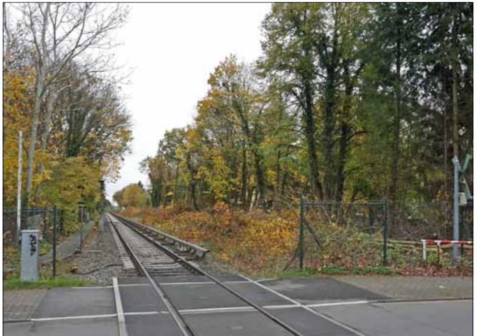
In Lichtenrade haben nach dem erfolgten Planfeststellungsbeschluss für die Dresdener Bahn die Baumfällungen auf der Bahntrasse begonnen. Foto: Florian Müller
